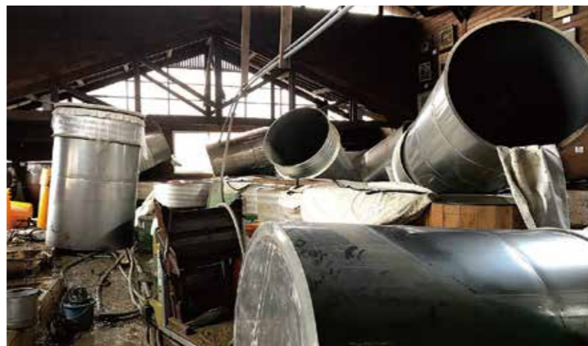
遭遇水災後工廠內部。因浮起而移動的貯藏用槽體散亂一地，釀造用的甕也受到許多損害
