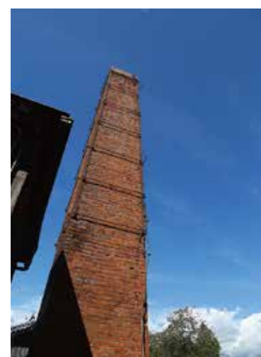
酒廠內還留有磚造的煙囪。到昭和 60 年左右為止，蒸餾用的能源還使用煤炭。
